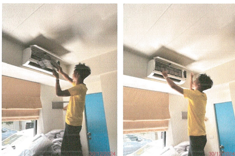
รูปภาพที่ 2.23 การล้างเครื่องปรับอากาศ
