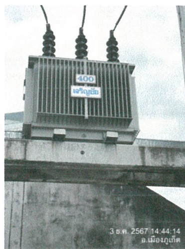
รูปภาพที่ 2.17 หม้อแปลงไฟฟ้า
